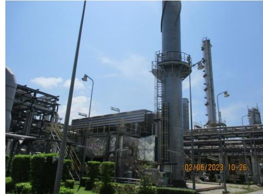
รูปที่ 1 Regenerative Thermal Oxidizer (RTO)
