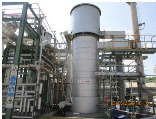
รูปที่ 2 ปล่องระบายของหม้อต้มน้ำมัน (HTM)
