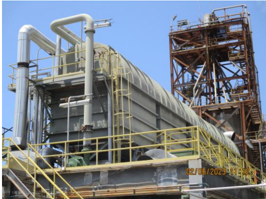
รูปที่ 1 Regenerative Thermal Oxidizer (RTO)
