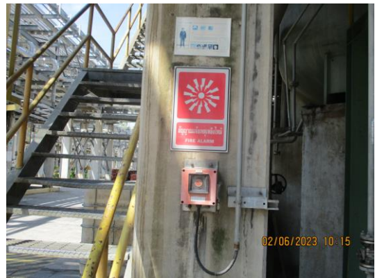
รูปที่ 28 สัญญาณเตือนภัย (Fire Alarm)
